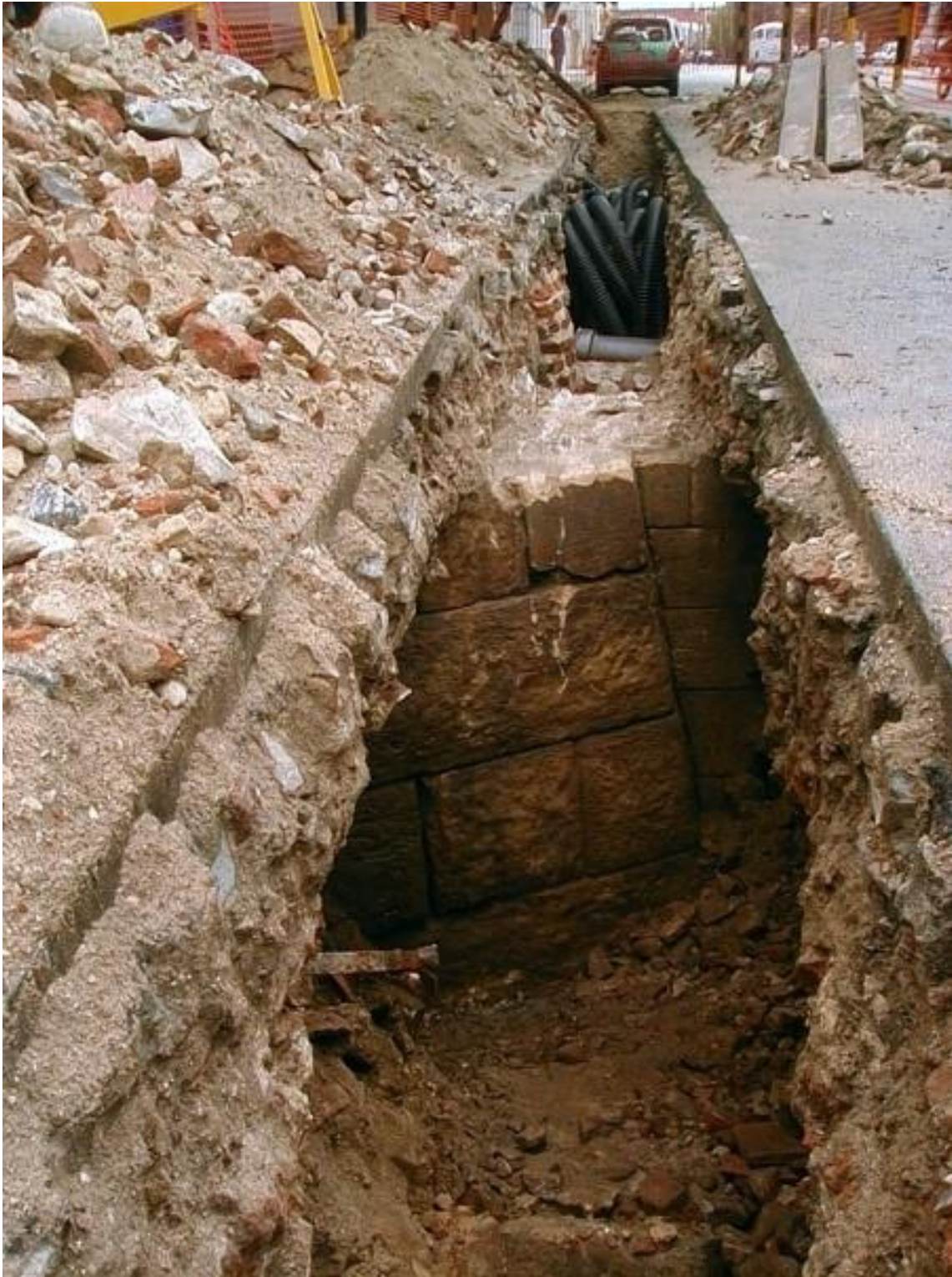
Figura 20: A vala aberta para embutir os dutos foi cuidadosamente escavada de modo a preservar as estruturas existentes. Em primeiro plano a face do baluarte, em pedras trabalhadas. Fonte: Albuquerque e Lucena, 2001.
