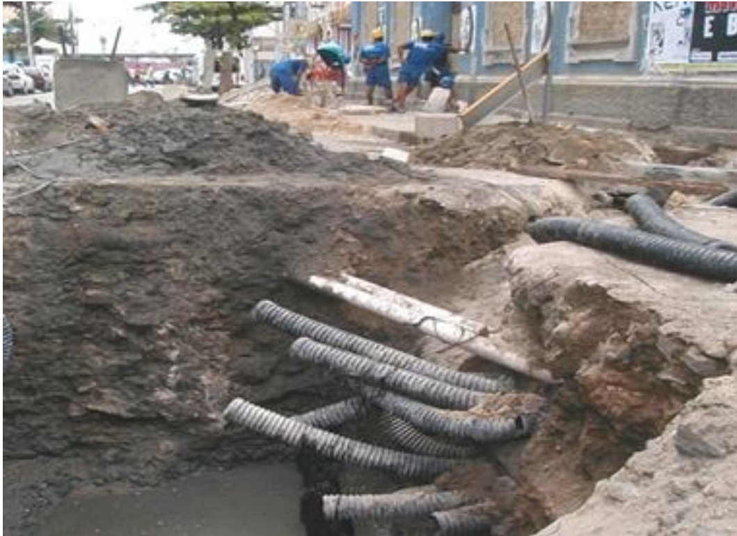
Figura 22: Abaixo do nível dos dutos pode-se ver as estacas, quase cobertas pela água. Fonte: Albuquerque e Lucena, 2001.
