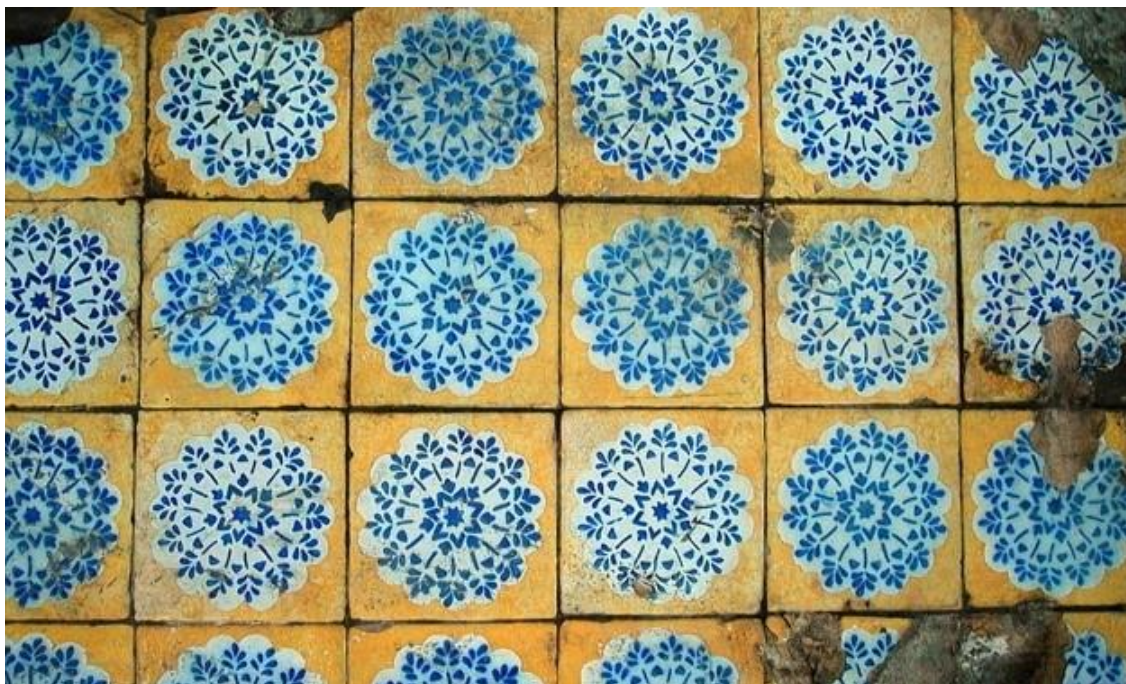
Figura 18: Detalhe dos azulejos que revestiam a parede do prédio. Fonte: Albuquerque e Lucena, 2001.
